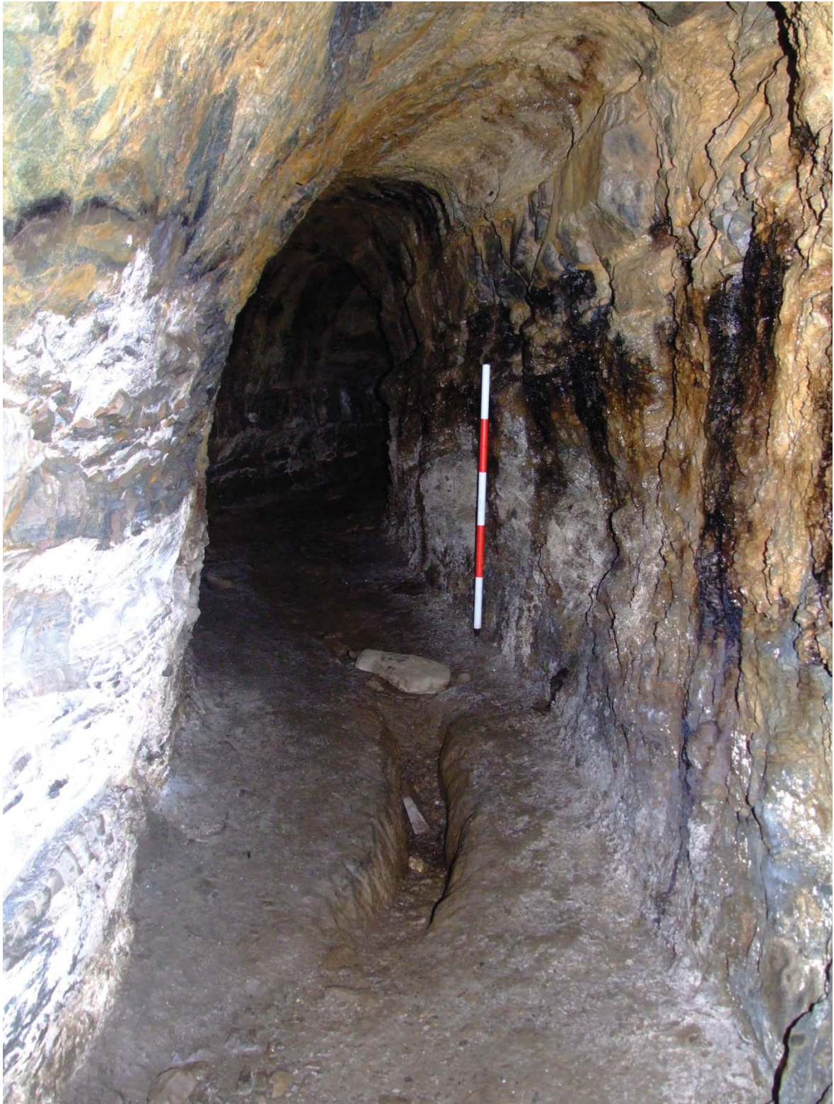
Galería romana de la Cueva de La Llama con cuneta de desagüe central)
