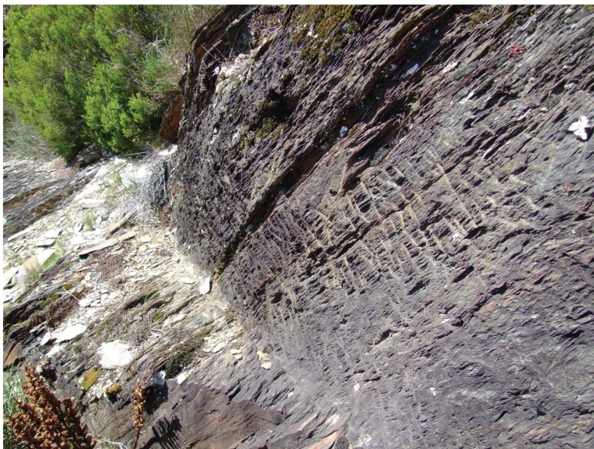
Huellas de picos en las paredes del nuevo tramo del canal C-4
